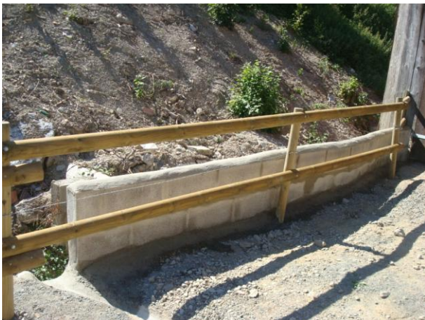
Construction d'un mur de protection et d'une barrière en bois imprégné. Ruisseau La Serbache / La Roche
