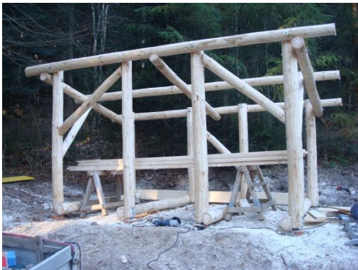
Le bûcher en construction
